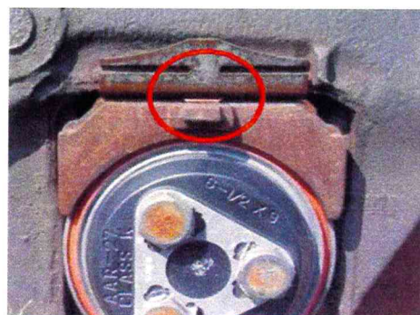
Рис. Г.3г Контроль износа верхних наружных поверхностей
