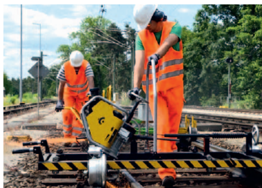
Шлифование стрелочных переводов
