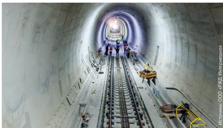
Работы по монтажу верхнего строения пути с применением RHEDA 2000® в тоннеле Чортановци, Сербия
